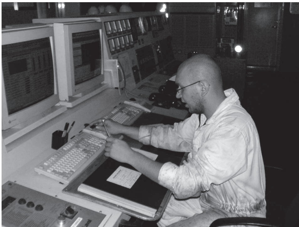
Rysunek 5. Centrala manewrowo-kontrolna współczesnego kontenerowca
